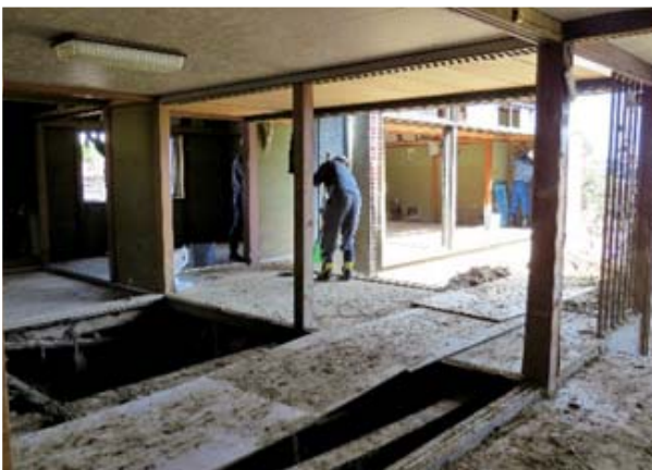
室内清掃作業
