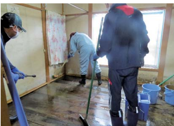
室内清掃作業
