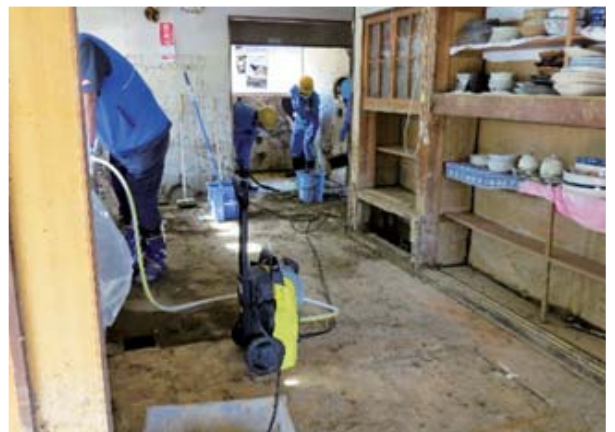
室内清掃作業
